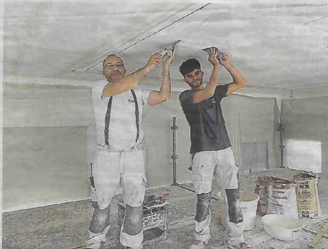
Baptiste Lamy (à droite) avec David Bonnin, son employeur, lors de la réalisation d'un plafond en staff, avec éclairage incorporé.
